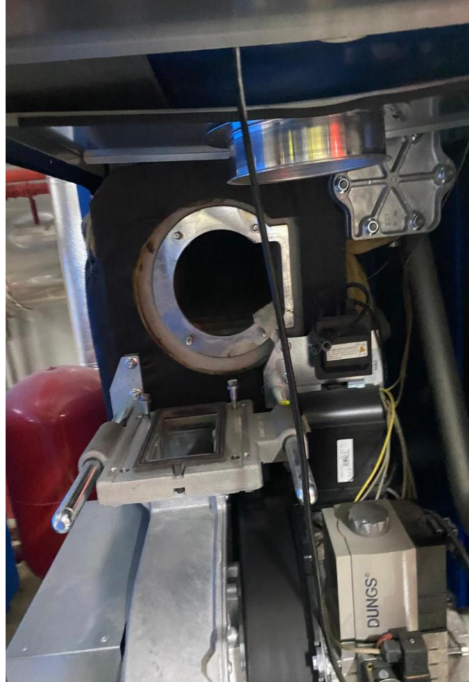
A blok kazan dairesi brülör temizliği yapılmıştır.
