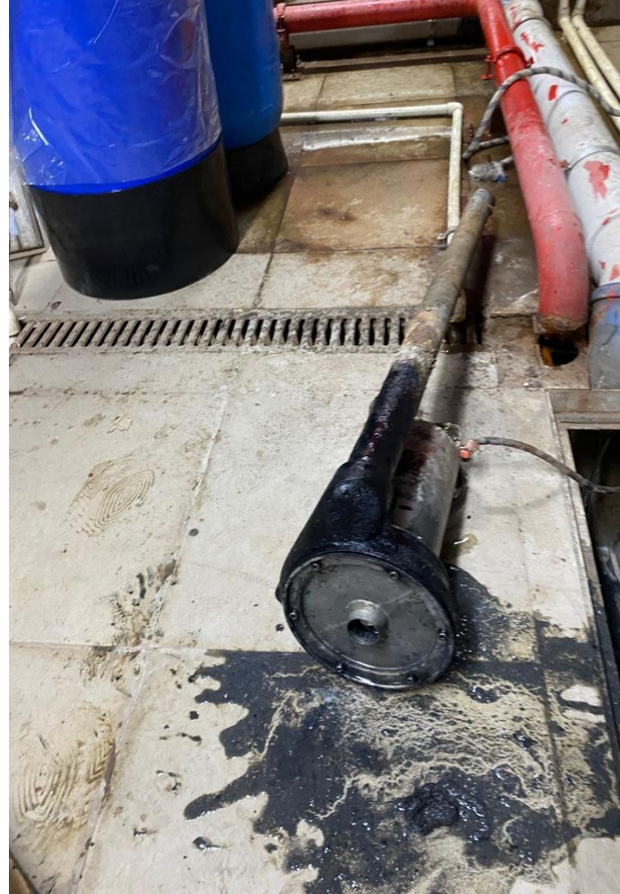
C blok kazan dairesi drenaj pompa temizliği yapılmıştır.
