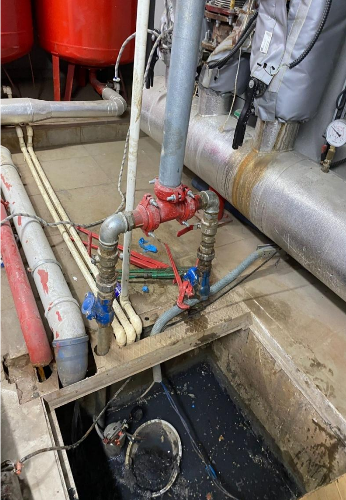
C blok kazan dairesi drenaj pompa temizliği yapılmıştır.
