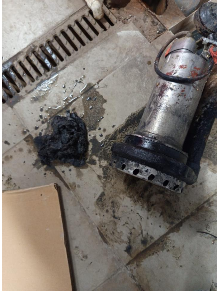
C blok kazan dairesi drenaj pompası sökülüp temizliği yapılmıştır.
