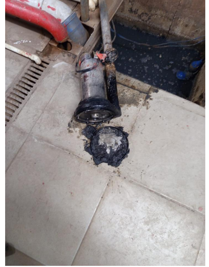
C blok kazan dairesi drenaj pompası sökülüp temizliği yapılmıştır.
