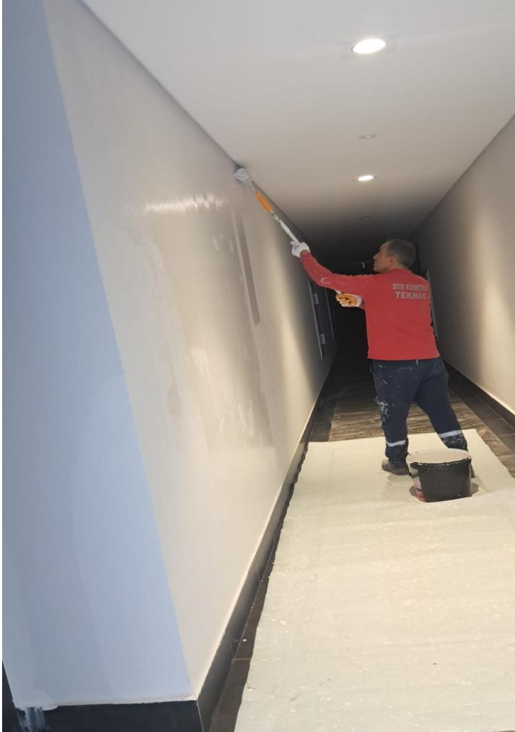
Ortak alan blok koridorlarında boyama işlemi yapılmıştır.
