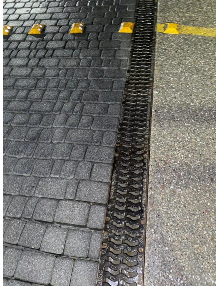
-3 otoparkı kasis montajı ve mazgalın sabitlenmesi yapılmıştır.
