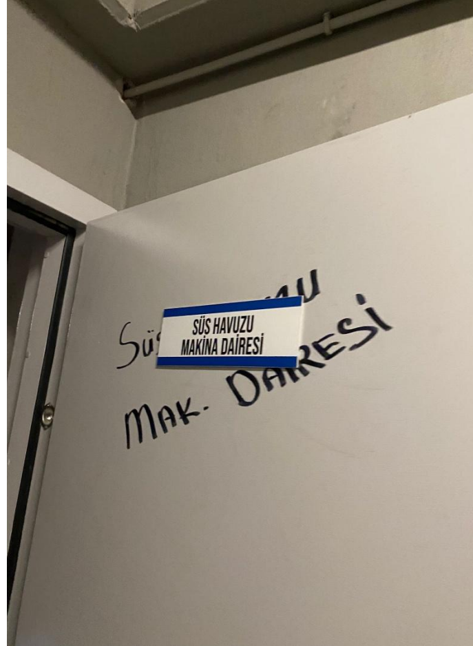
Süs havuzu ters yıkama yapılmıştır.
