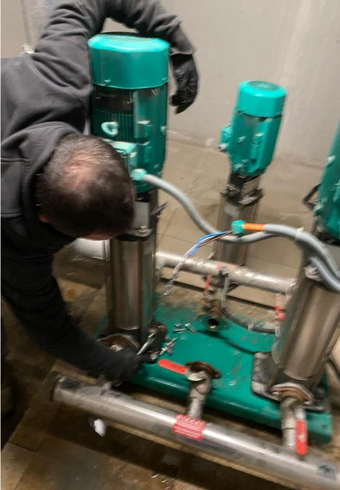
F bloкта arızalı hidrofor pompası wilo servisi tarafından bakımı yapılmıştır
