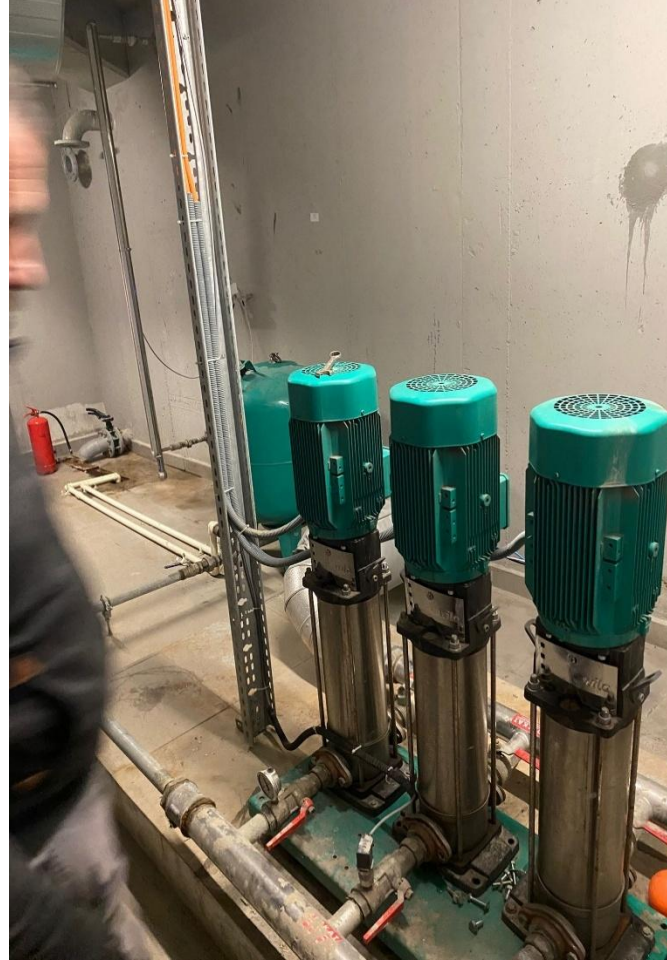
F bloкта arızalı hidrofor pompası wilo servisi tarafından bakımı yapılmıştır
