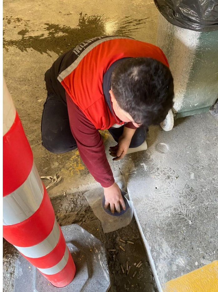
-3 otopark gideri süzgeçleri takılmıştır.
