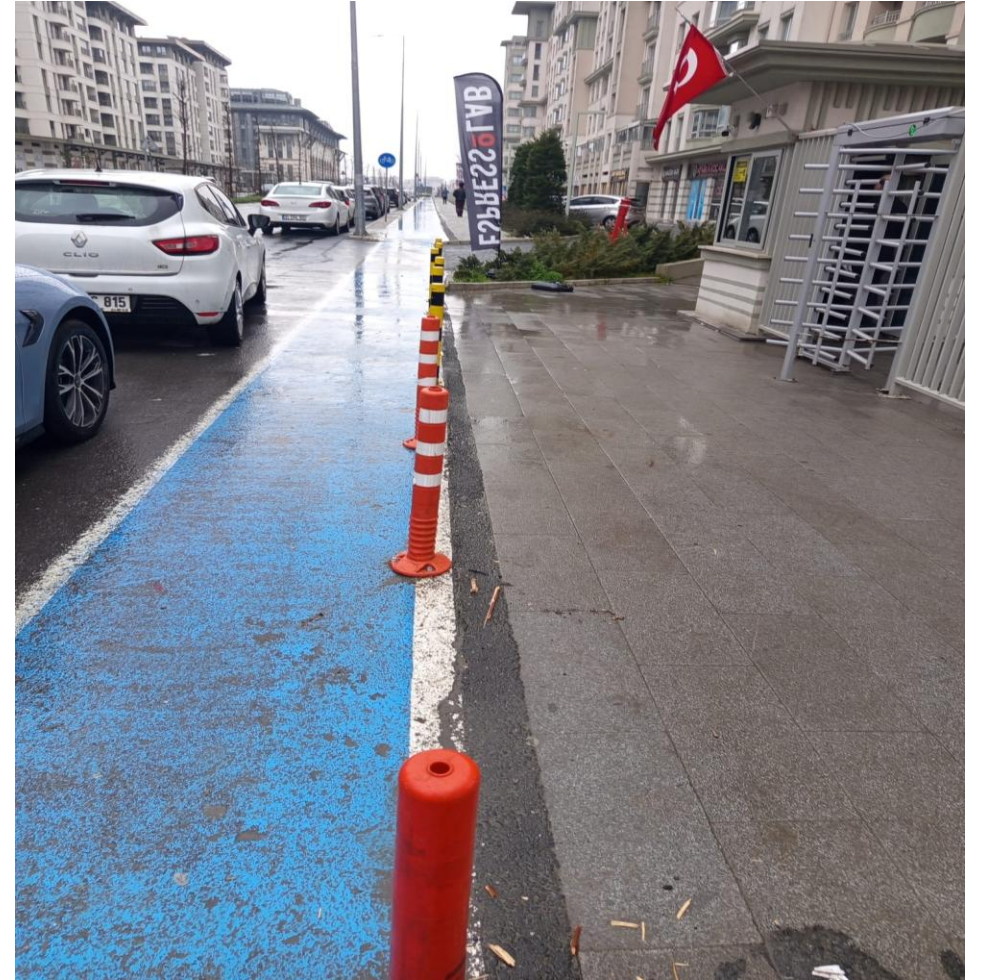
Yaya giriş turnike önü duba montajı yapılmıştır.
