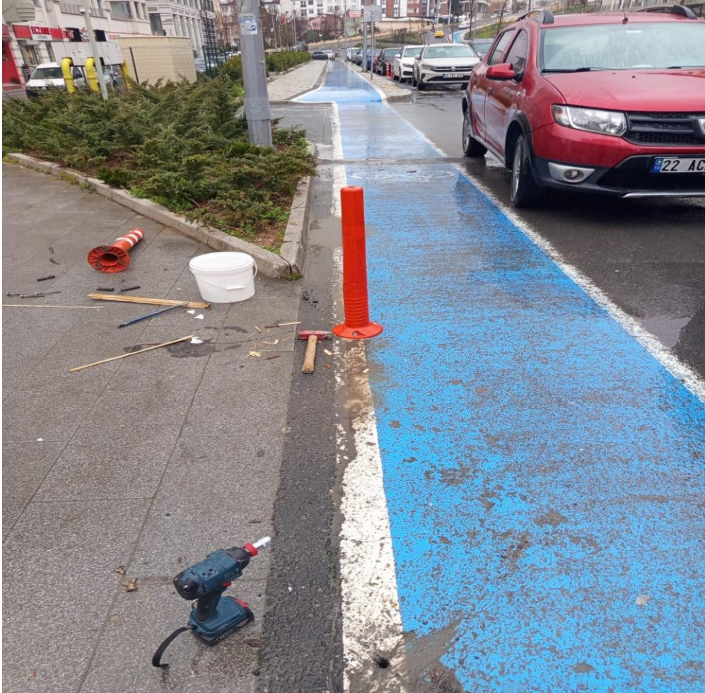
Yaya giriş turnike önü duba montajı yapılmıştır.
